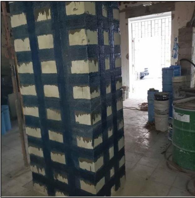
Revestimiento de fibra de carbono en columnas
