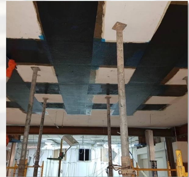
Plataforma de fibra de carbono en planchas existentes
