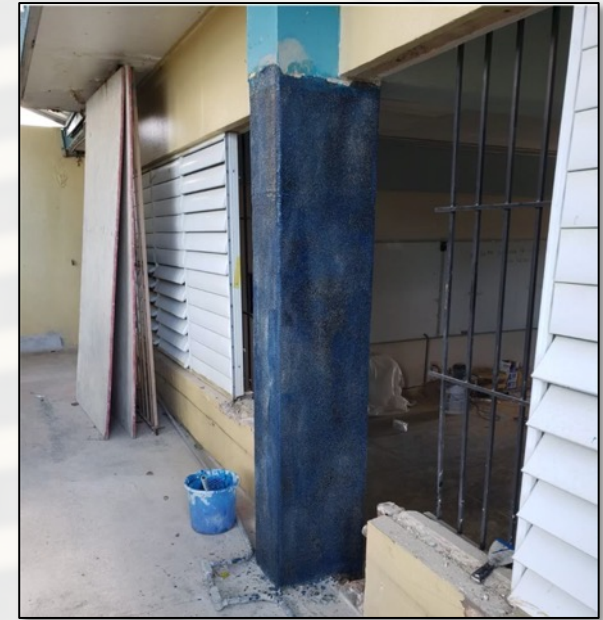
Revestimiento de fibra de carbono en columnas
