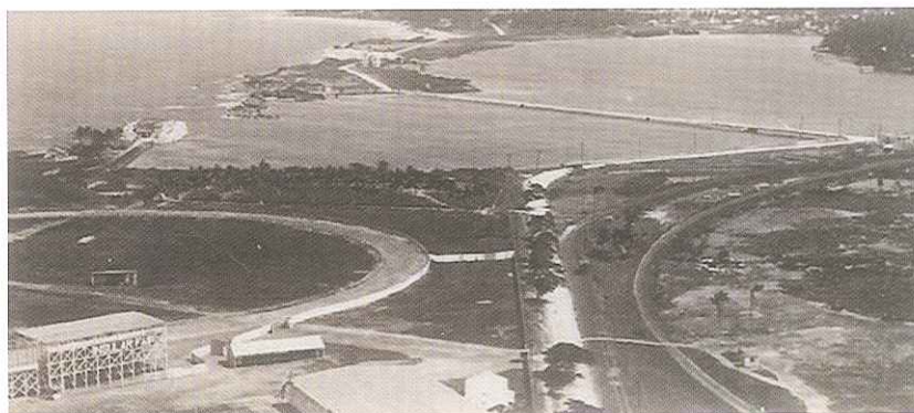
Vista aérea del puente que conecta la isleta de San Juan con el área del Condado, denominado como Puente Dos Hermanos, en honor a Sosthenes y Hernán Behn, quienes financiaron la construcción del mismo, 1915.
